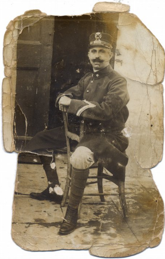
L'originale della fotografia con evidenti danneggiamenti conseguenti ad un cattivo stato di conservazione.
